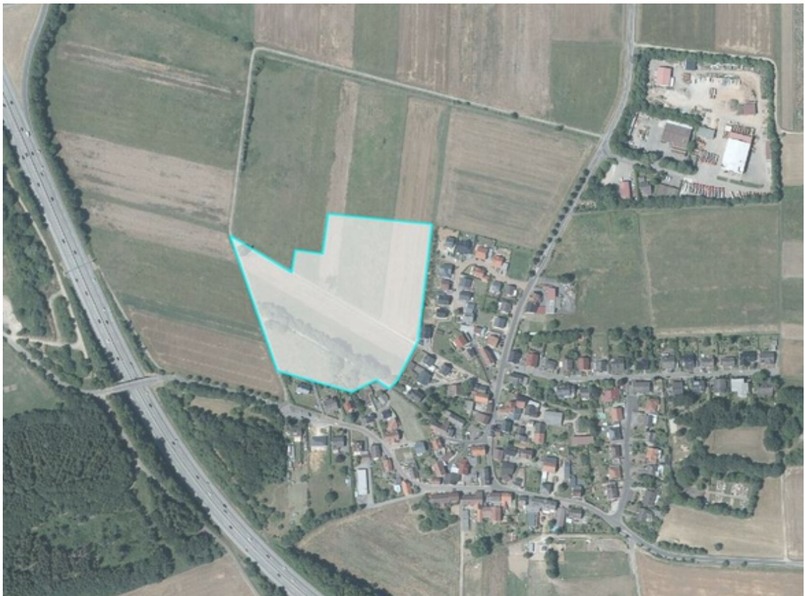
Luftaufnahme des Betrachtungsraums (Quelle LANIS)
